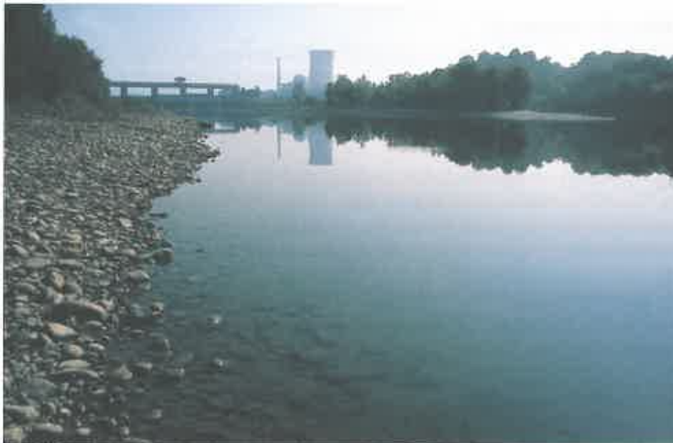
Restwasserstrecke am Hochrhein unterhalb des Kraftwerks Albruck-Dogern; fast stehende Wasserverhältnisse bewirken eine Verschlämzung der Flußsohle.
