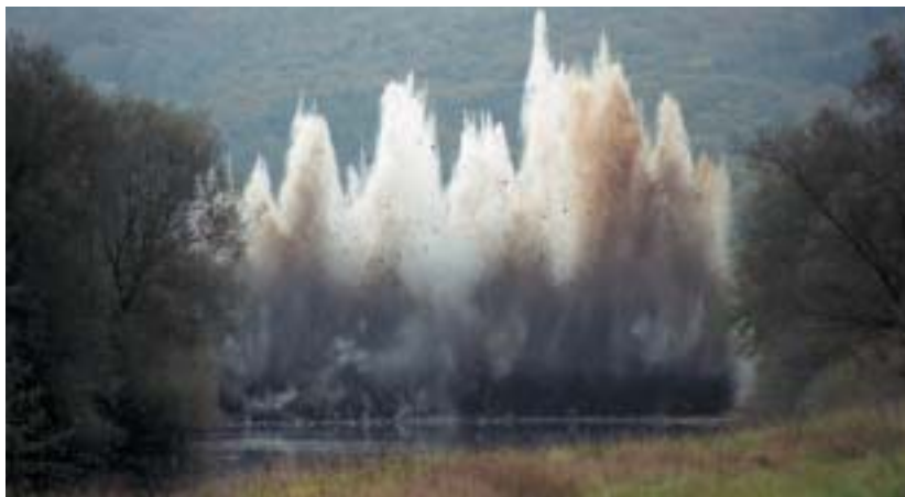
Sprengrung des Wehrs an der Sauer Schleife in Luxemburg mit Unterstützung durch das Land Rheinland-Pfalz
