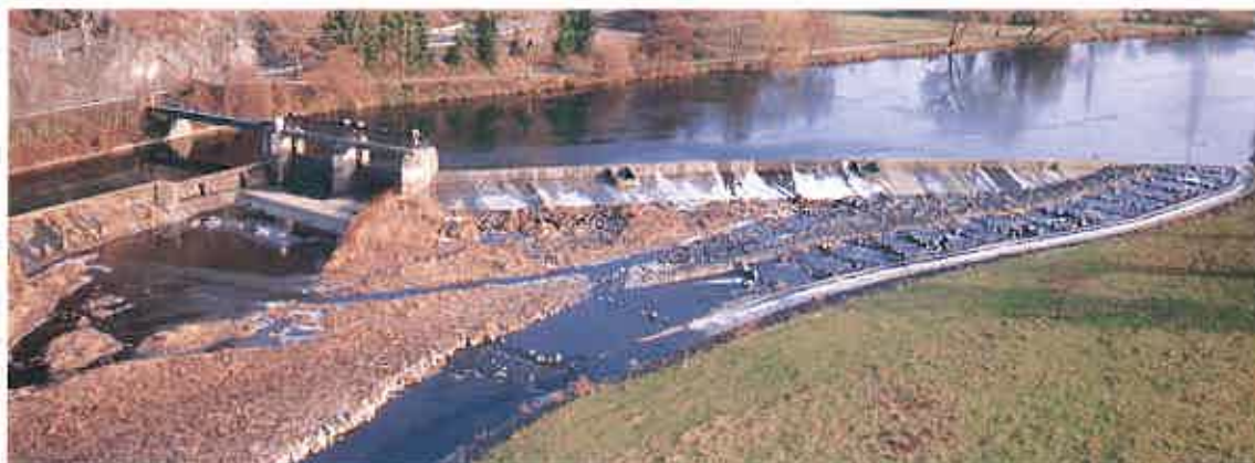
Barrage sur la Sieg avec nouvelle échelle à poissons
