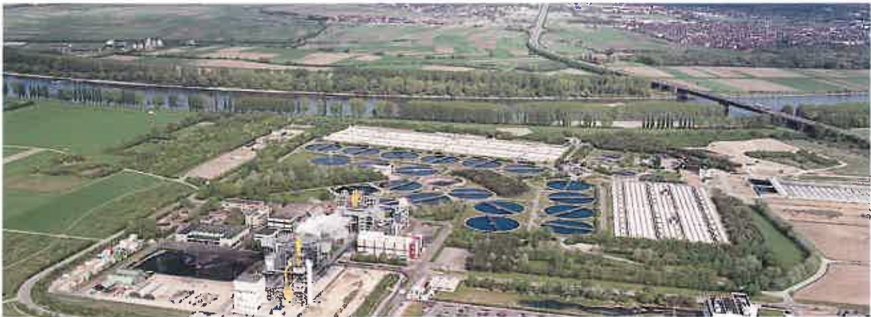
Station d'épuration des eaux usées sur le Rhin près de Ludwigshafen
