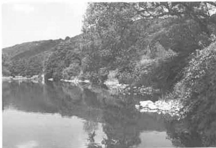
Structure des rives par le biais d'épis sur le cours supérieur de la Sieg (Photo: Schlösser)
