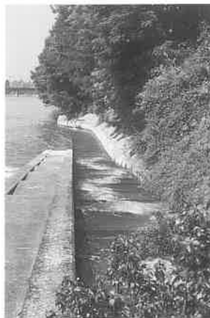
La passe à poissons installée sur la centrale de Birsfelden sur le haut Rhin semble être appropriée pour la migration piscicole, comme l'attestent les essais réalisés lors de la remontée des poissons (Photo: E. Staub)
