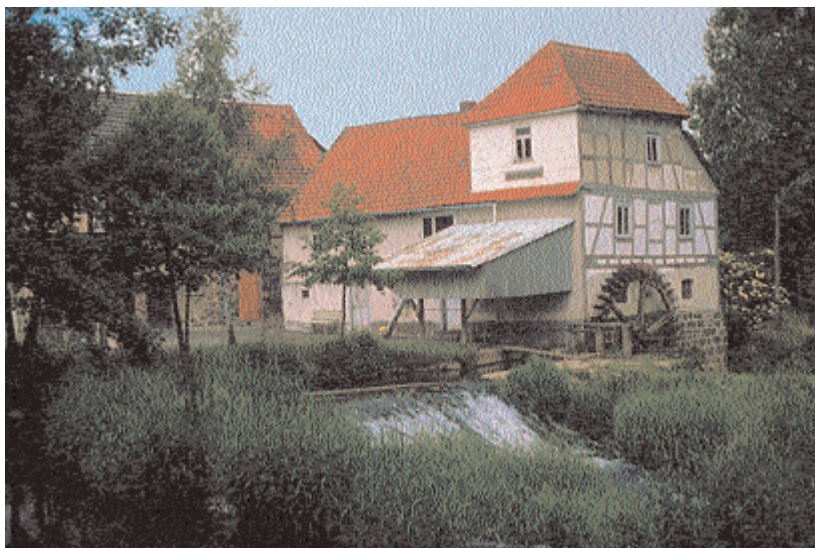
Le barrage du moulin de Rossel sur la Felda dans l'hydrosystème de la Lahn-Ohm n'a pas de dispositif de franchissement
