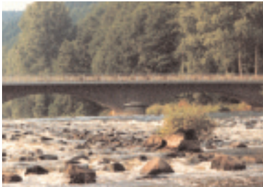
Dispositif moderne de remontée au barrage de Dattenfeld sur la Sieg
