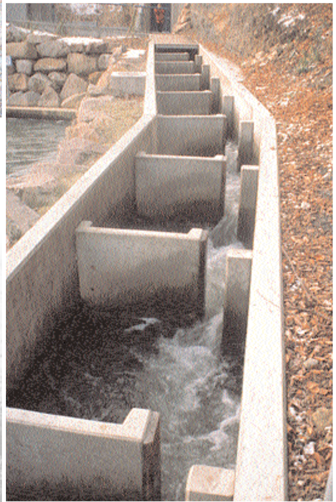
Passé à fentes pour saumons sur la centrale « Neue Welt » dans la Birs à hauteur de Münchenstein.
