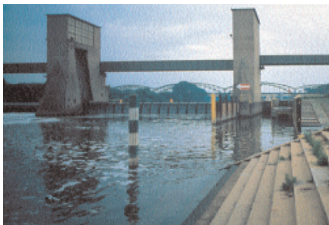
Le premier barrage sur le Main à hauteur de Kostheim est équipé d'une passe à bassins non fonctionnelle et entrave la migration des poissons venant du Rhin
