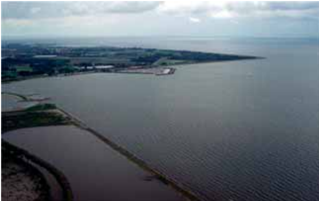
L'érosion des berges par le battement des vagues (effet du vent) est contenue à l'aide de constructions de protection offrant simultanément des conditions propices au développement d'une végétation riveraine typique des prairies humides (photo : RWS RIZA)
