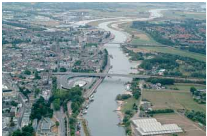
Arnhem avec au nord la mesure de mise en retrait de digues de « Bakenhof » (photo : B. Beekhoven)
