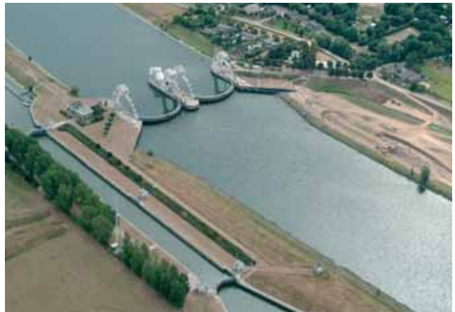
Le barrage de Hagestein avec la passe à poissons en cours de construction (photo : B. Boekhoven)
