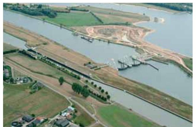
Le barrage d'Amerongen avec la passe à poissons en cours de construction (photo : B. Boekhoven)
