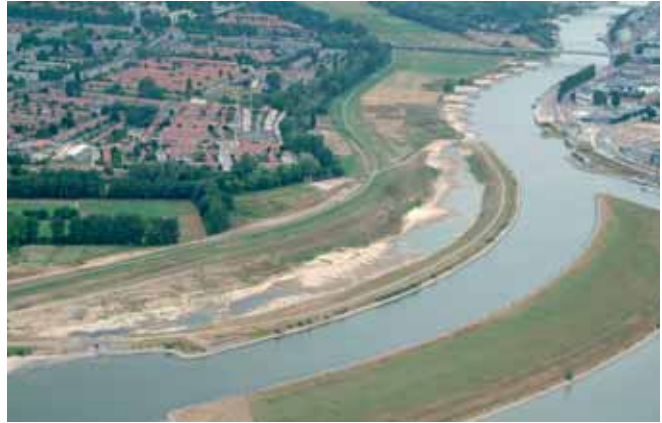
Combinaison de mesures de prévention des crues et de restauration écologique : la mise en retrait de digues au niveau de « Bakenhof » (photo : B. Beekhoven)
