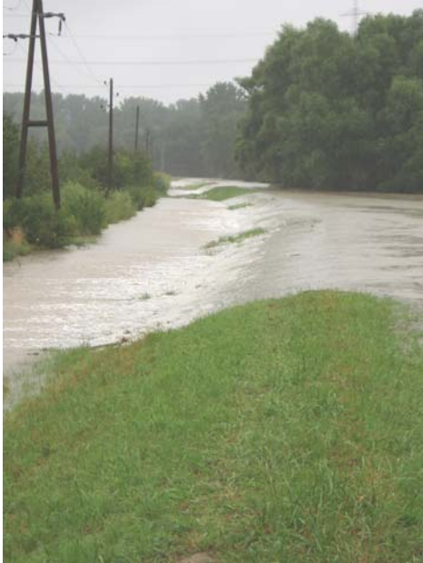
Digue d'été côté Rhin en situation d'inondation et montée des eaux dans une zone poldérisée
