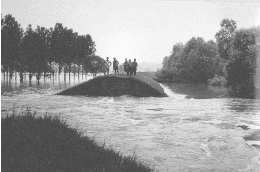
Rupture de digue sur le Rhin supérieur à Flotzgrün (crue de juin 1953)
