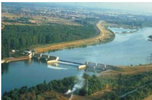
Barrage agricole de Kehl/Strasbourg
