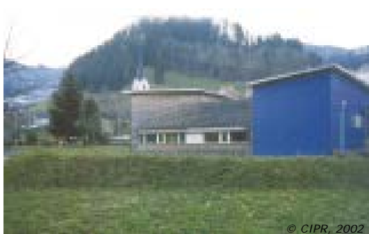
Petites digues de protection
