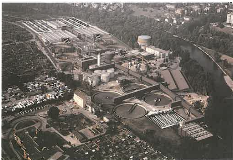
Rioolwaterzuiveringsinstallatie "Werdhözli" van de stad Zürich
