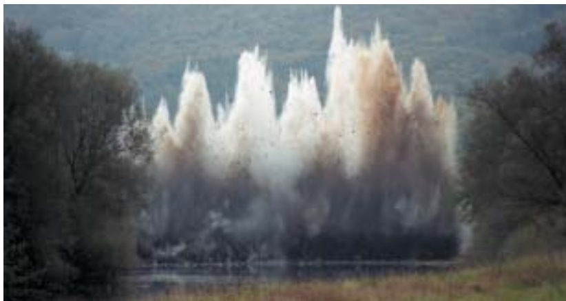
Het opblazen van een stuw aan de Sauer in Luxemburg met ondersteuning van Rijnland-Palts
