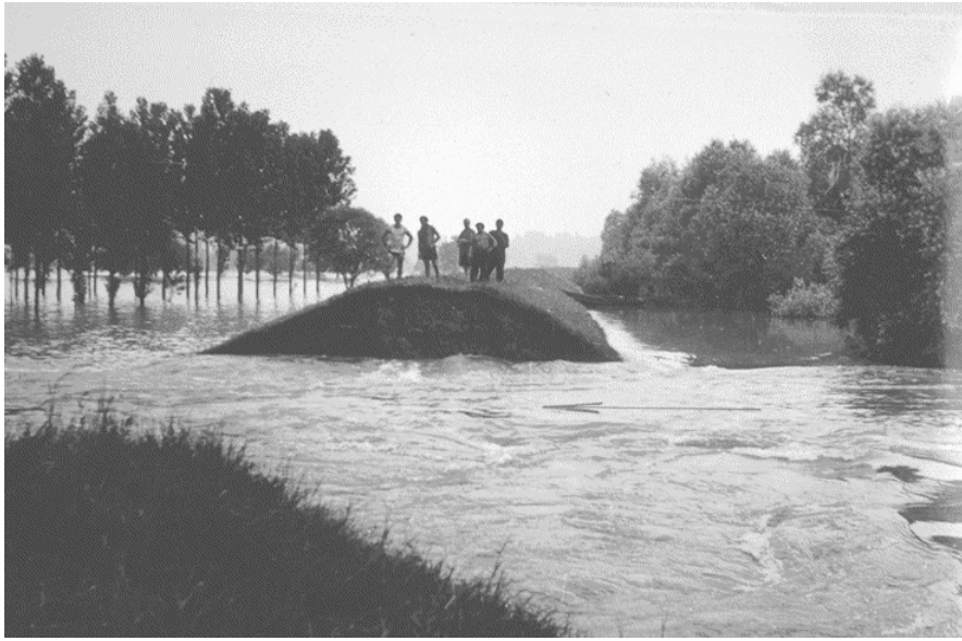
Dijkdoorbraak aan de Duitse Bovenrijn in Flotzgrün (hoogwater in juni 1953)
