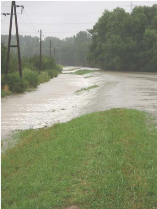
Zomerkade langs de Rijn bij overstrooming in een poldergebied met stijgend waterpeil.
