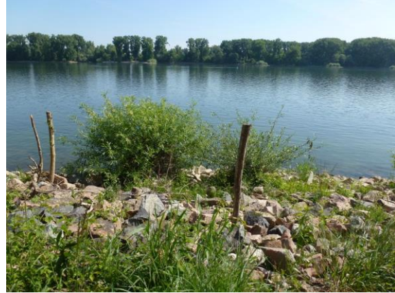
Figuur 21: Groene steenbestorting met uitlopende poten
