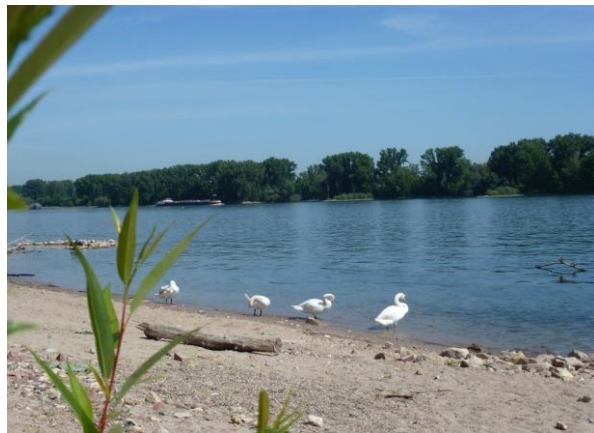
Figuur 22: Oevertraject na uitgevoerde werkzaamheden
