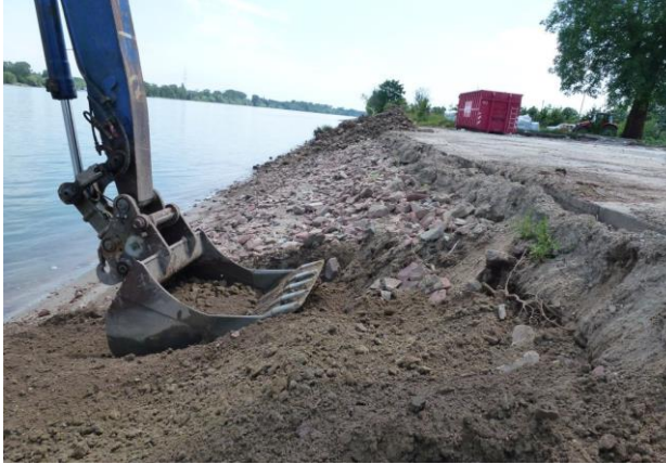
Figuur 20: Verwijderingswerkzaamheden langs de oever
